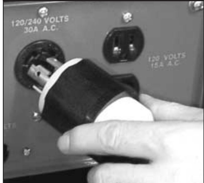
Figura 32 — Alinee los Conectores en el Generador
